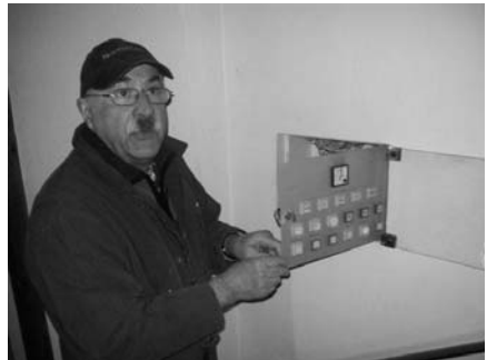
Siegfried Rottler ist zuständig für die Elektroanlage in St. Albertus
